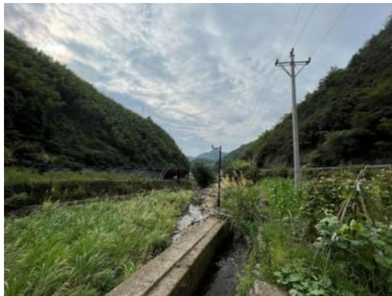
生态流量监控设施
