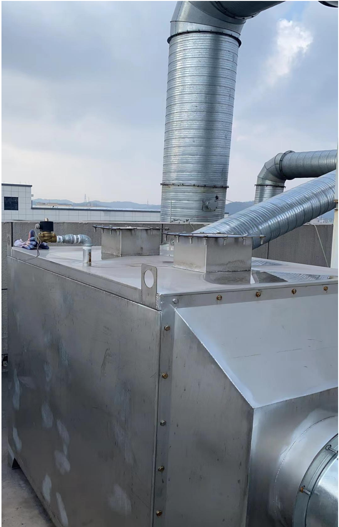
挤出、压片废气处理设施
