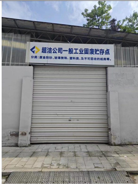
一般固废暂存库（外）
