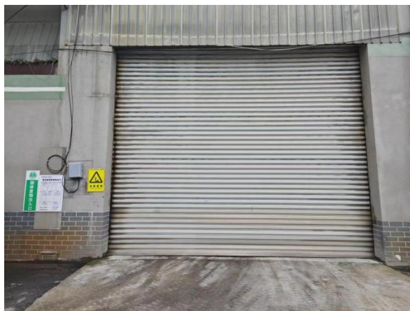
危险固废暂存库（外）
