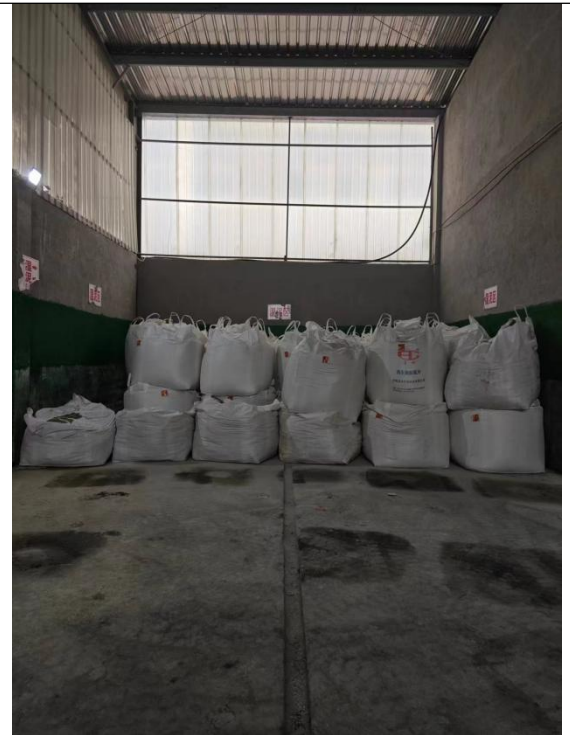
危险固废暂存库（内）
