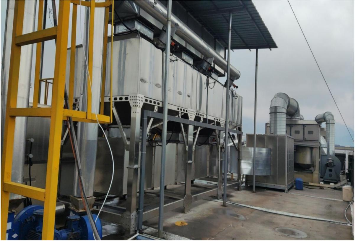
调漆、喷漆、烘干、固化、丝印、天然气燃烧废气处理设施
