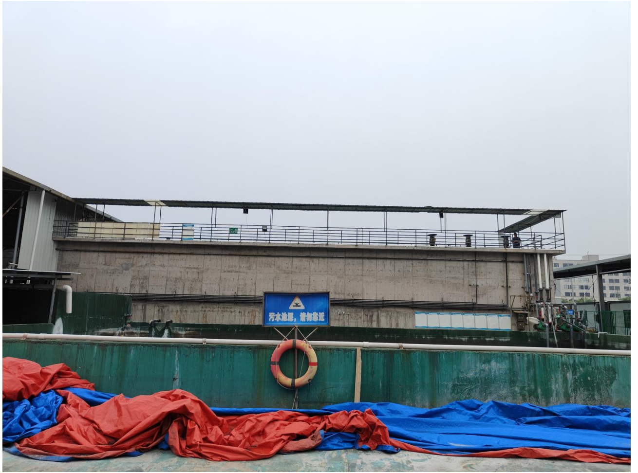
附件 4 废水处理设施照片
