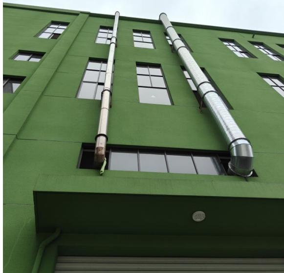
高档不锈钢锅具热处理废气排气筒
